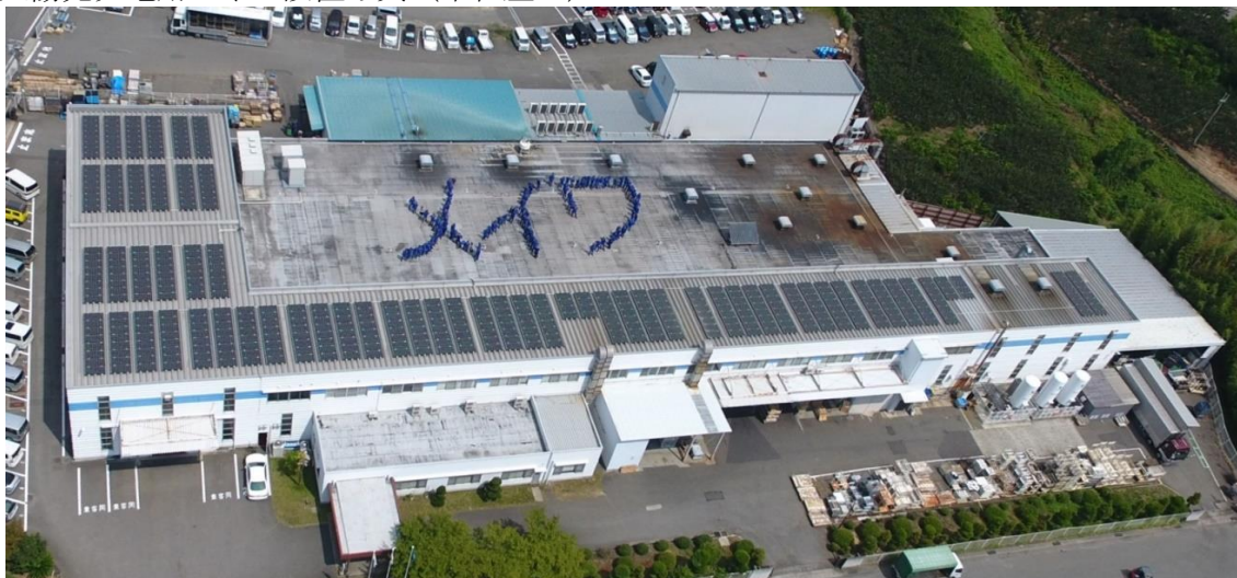
太陽光発電用パネル設置写真（本社屋上）
